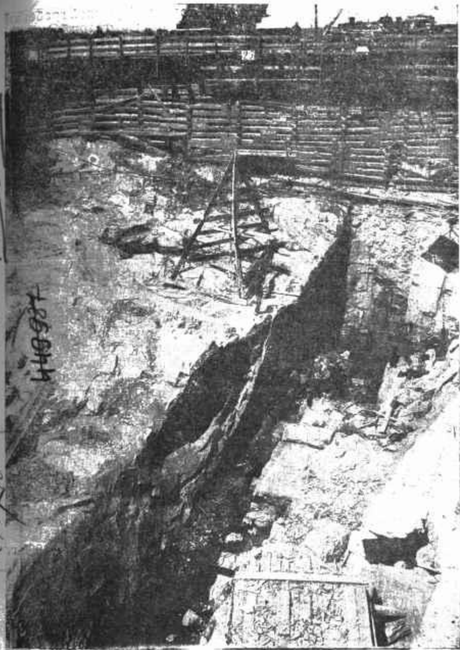
Рис. 7. Скала под основанием плотины
