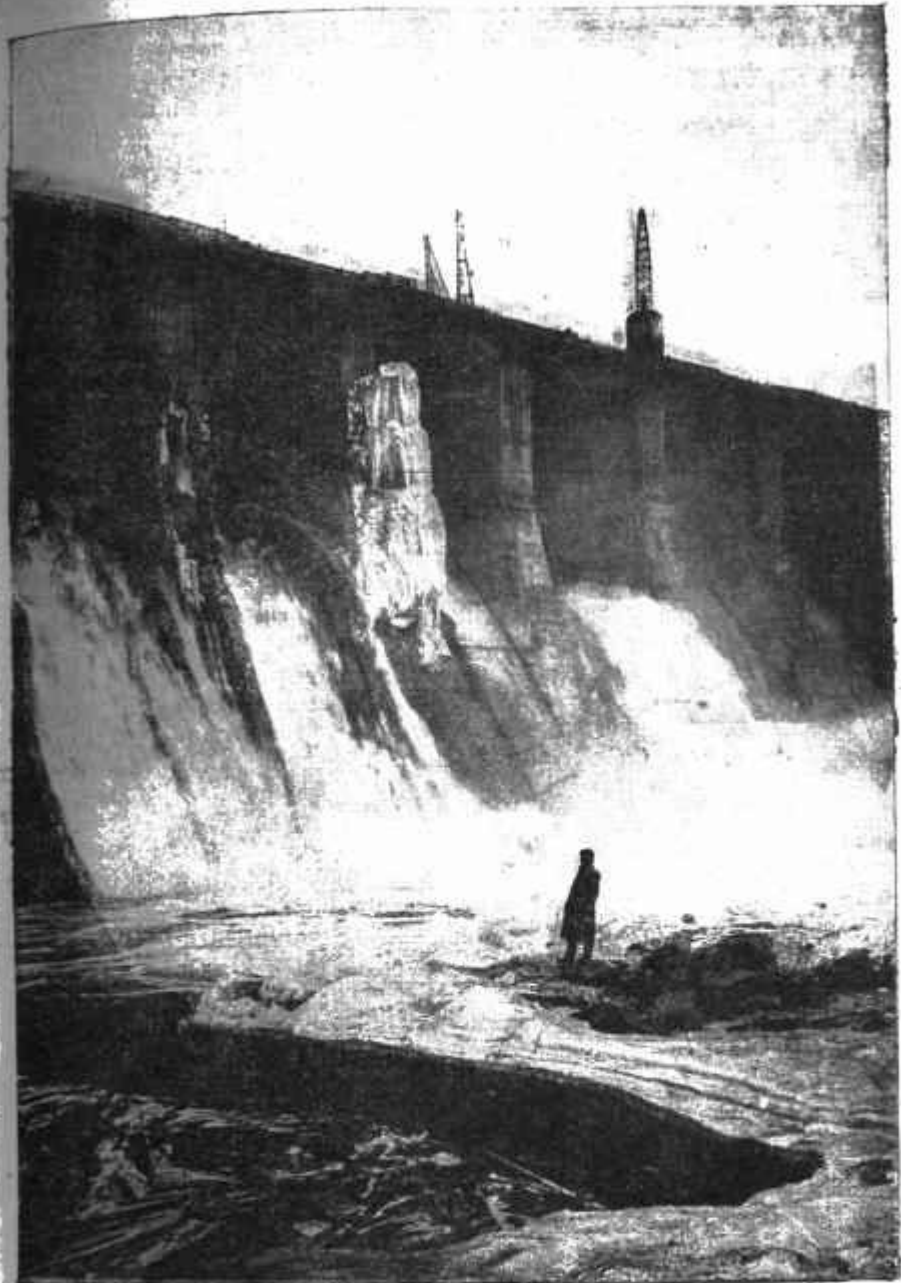
Рис. 13. Перед окончанием закрытия гребенки в марте 1932 г.
