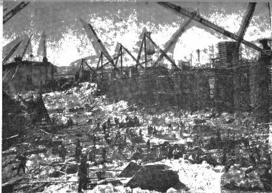
Рис. 8. Подготовка основания под пюгину среднего прогска.
