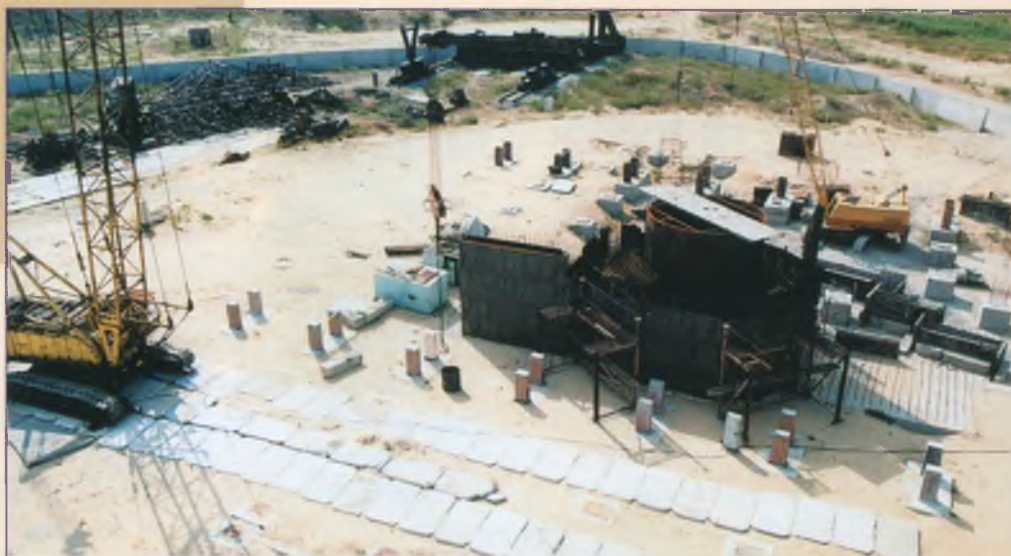
Строительство ПМТ для ремонтного персонала
