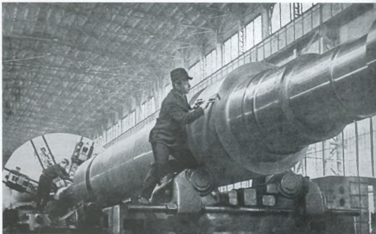
**Первая цельнокованная поковка ротора генератора 800 МгВт
