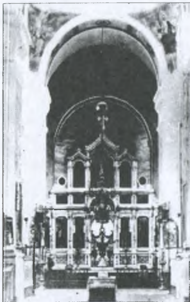
Свято-Троїцька церква (Внутрішній вид)
