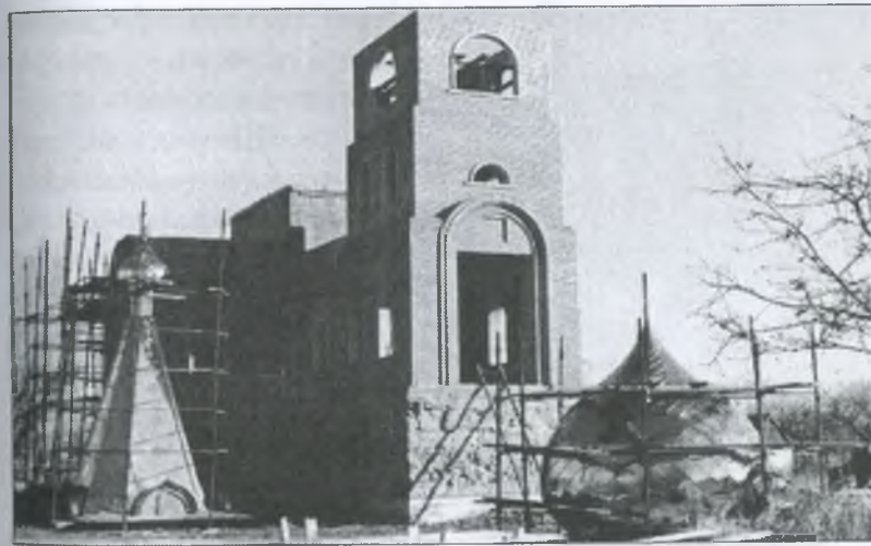
Будівництво церкви святого мученика Олександра. 4.11.2004 р.
