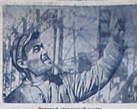
Четвертый строительный участок. На снимке: бригадир монтажников Михаил Абрамович Жидовский...
