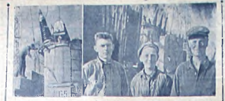
Восстановительные работы на ремонтном цехе. На снимке слева направо: электромонтажник М. Шивачев, Чехо и автотроллейсер в. Мирошкин, фото И. Петра.
