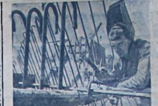
НА ДНЕПРОСТРОЕ Электросварщик И. Горшков на сварной арматуре на шпотовой стелле. Фото Р. Лягачева.
