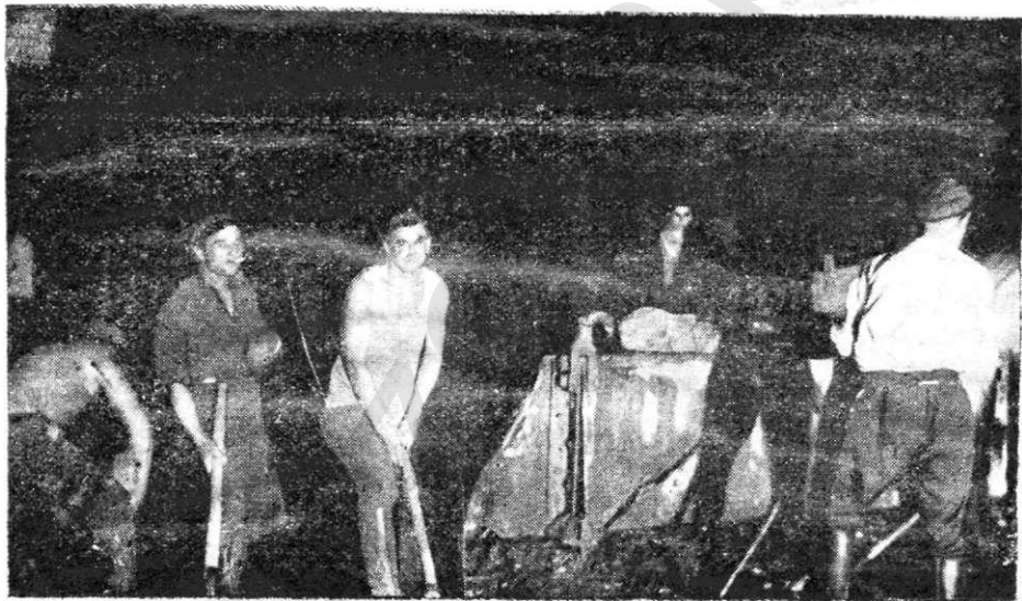
Ударная бригада работников Запорожского окротдела ГПУ на ликвидации прорыва по скальной выемке в среднем котловане (ночью).
