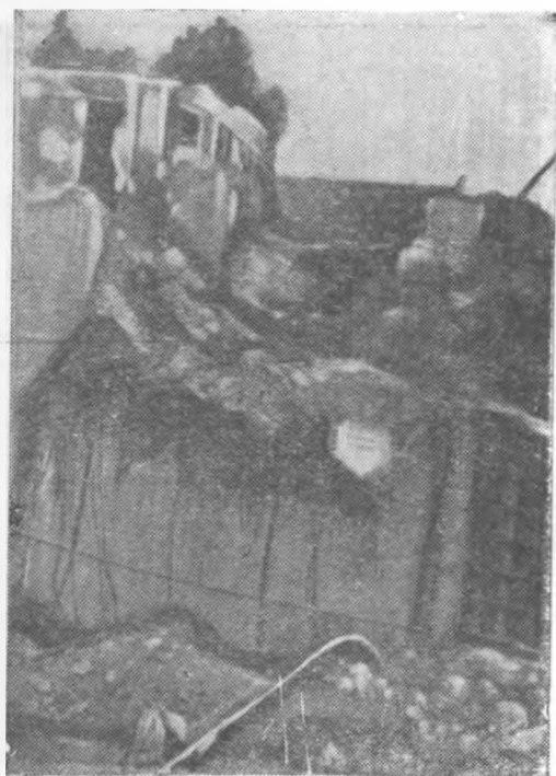
Фиг. 4. Береговой устой моста.
