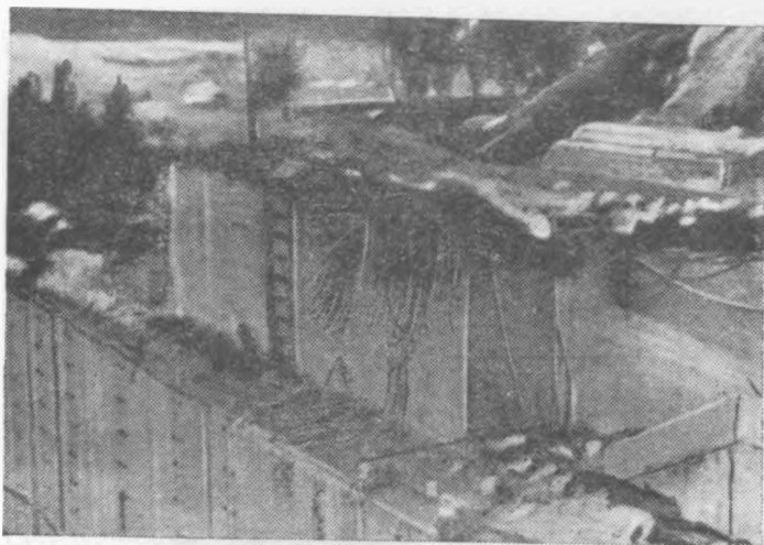
Фиг. 5. Речной устой моста.
