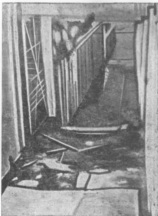
Фиг. 8. Вторая голова и вторая камера шлюза. Поврежденный участок водопроводной гал- лерей.
