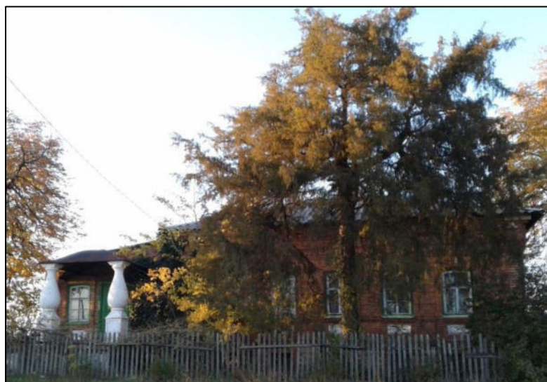
«Карпушин будинок», загальний вигляд
