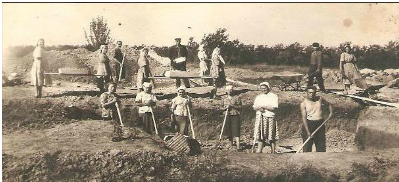
Рис. 1. Будівництво будівлі РАГСу у с. Велика Білозерка
